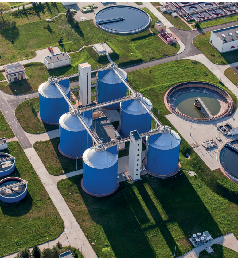
Luftaufnahme einer Kläranlage. Bildquelle: © shutterstock.com 279357398
